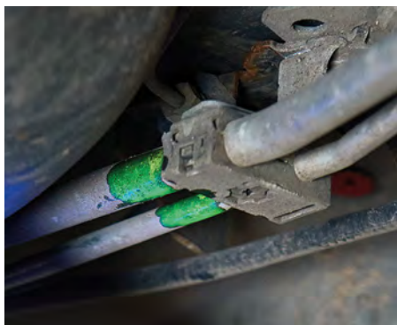
Perdita sulla tubazione del refrigerante dell'impianto aria condizionata di un veicolo, con luce UV tramite contrasto.
